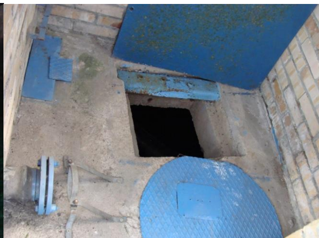
Otwór rewizyjny, widoczna warstwa dociskowa betonu
